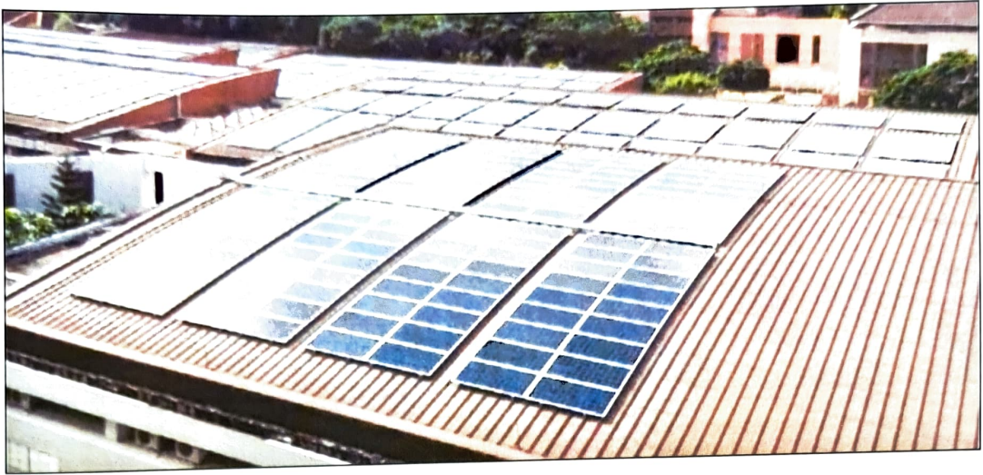
ภาพที่ ตัวอย่างการติดตั้งระบบผลิตไฟฟ้าพลังงานแสงอาทิตย์บนหลังคา
